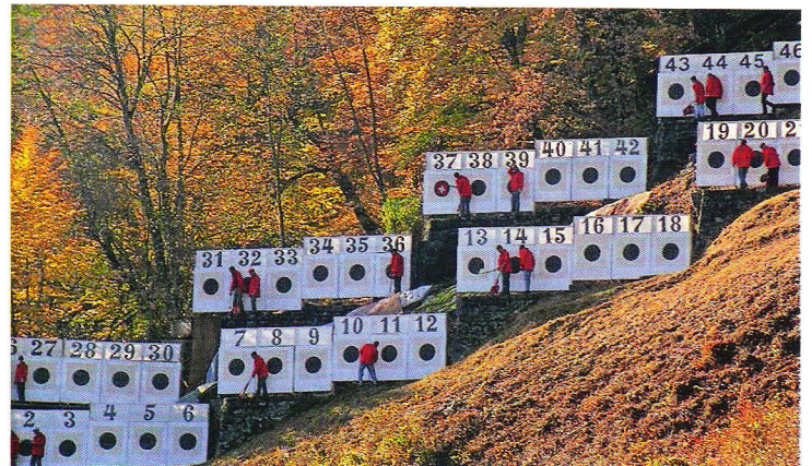
Im Interesse der Sicherheit (Steinschlag-Schutz) wird der Scheibenstand saniert.
