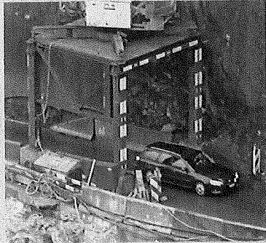
Technische Probleme: Die Baustelle Gibelhorn. Bild Geri Holdener
